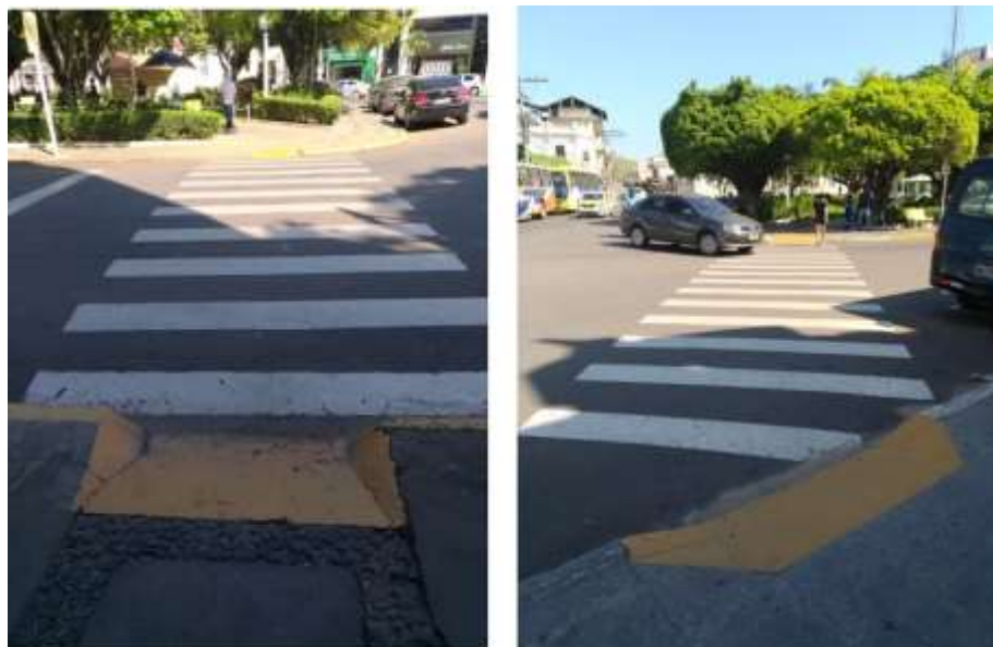
Figura 44: Rampas “acessíveis” Fonte: Acervo Próprio
