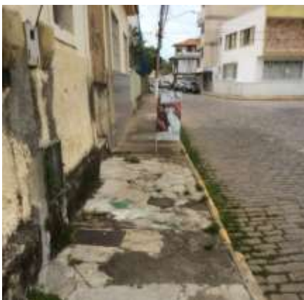
Figura 36 – Calçada lado direito – Duque de Caxias Fonte: Acervo Próprio
