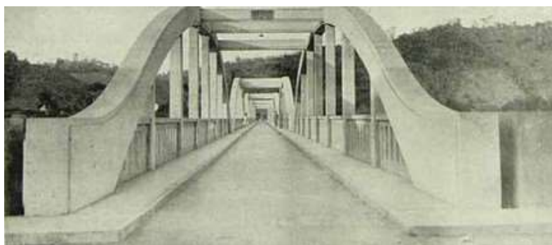
Figura 08 – Ponte Raul Veiga.
