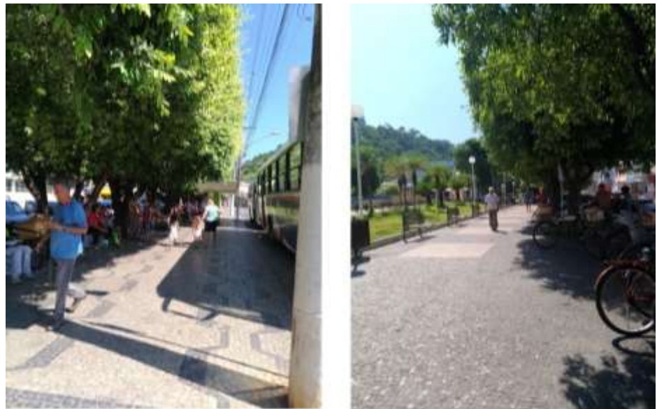
Figura 48: Inexistência de piso tátil Fonte: Acervo Próprio
