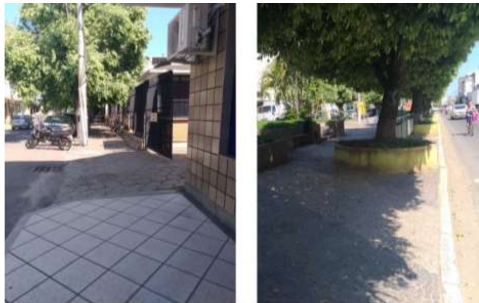
Figura 49: Inexistência de piso tátil Fonte: Acervo Próprio
