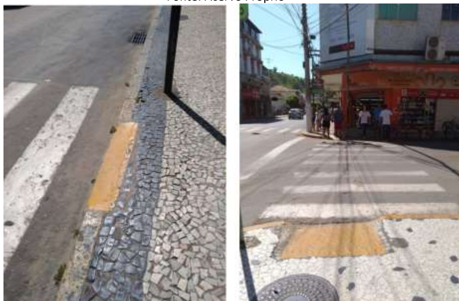
Figura 45: Rampas “acessíveis” Fonte: Acervo Próprio
