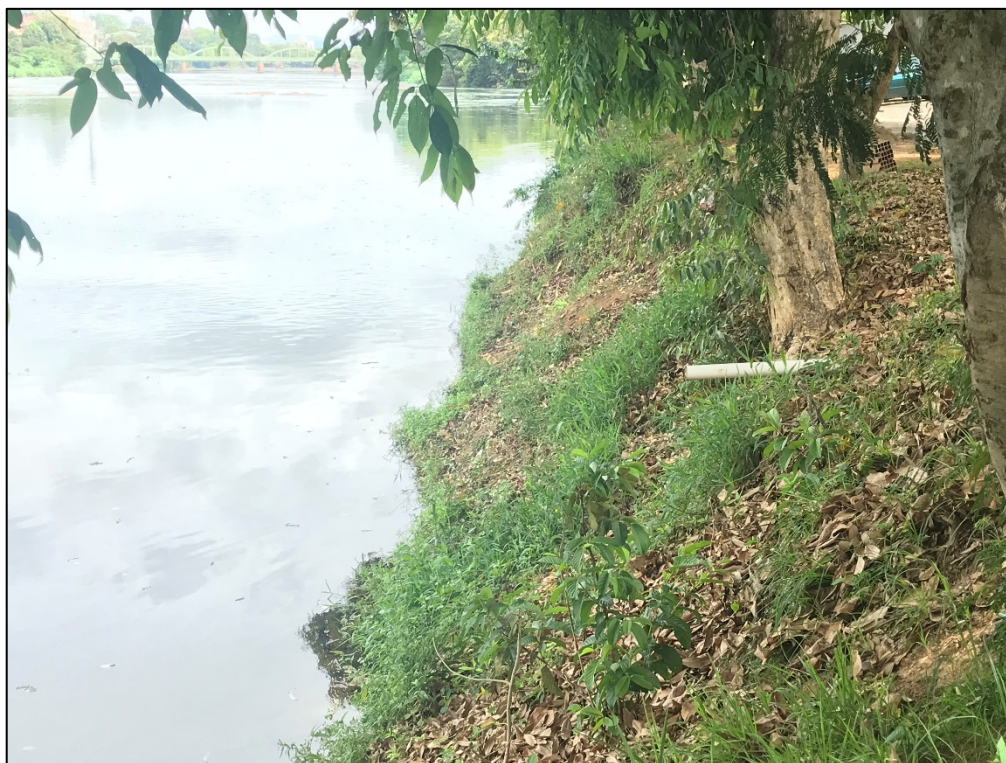
Figura 3.3 - Tubulação, Rio Pomba.
