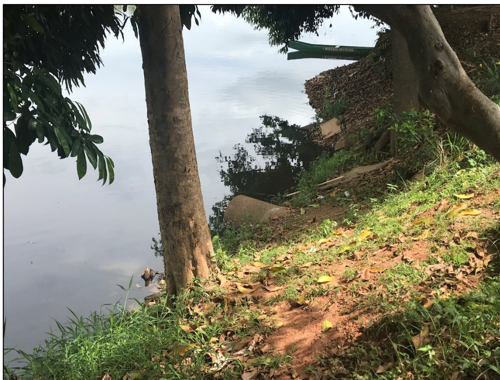
Figura 3.2 – Galeria de drenagem, Rio Pomba.
