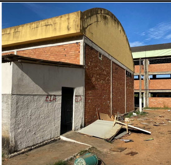
Foto 04 - Banheiro Feminino 02/Galpão 02
