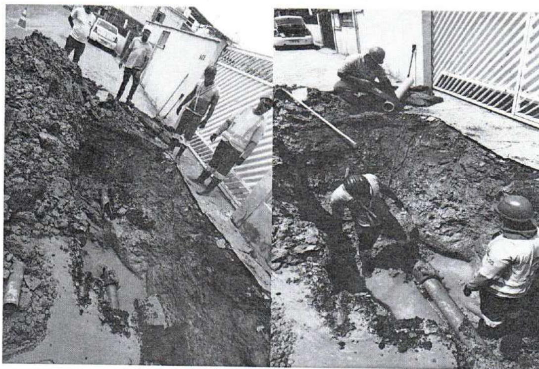
Figura 4; manutenção emergencial rede de 160mm.
