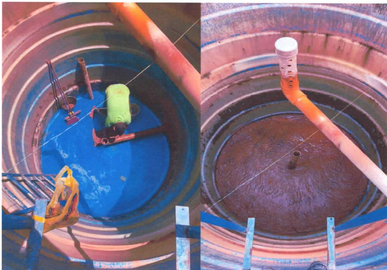
Figura 5; funcionários retirando todo o lodo do decantador.
