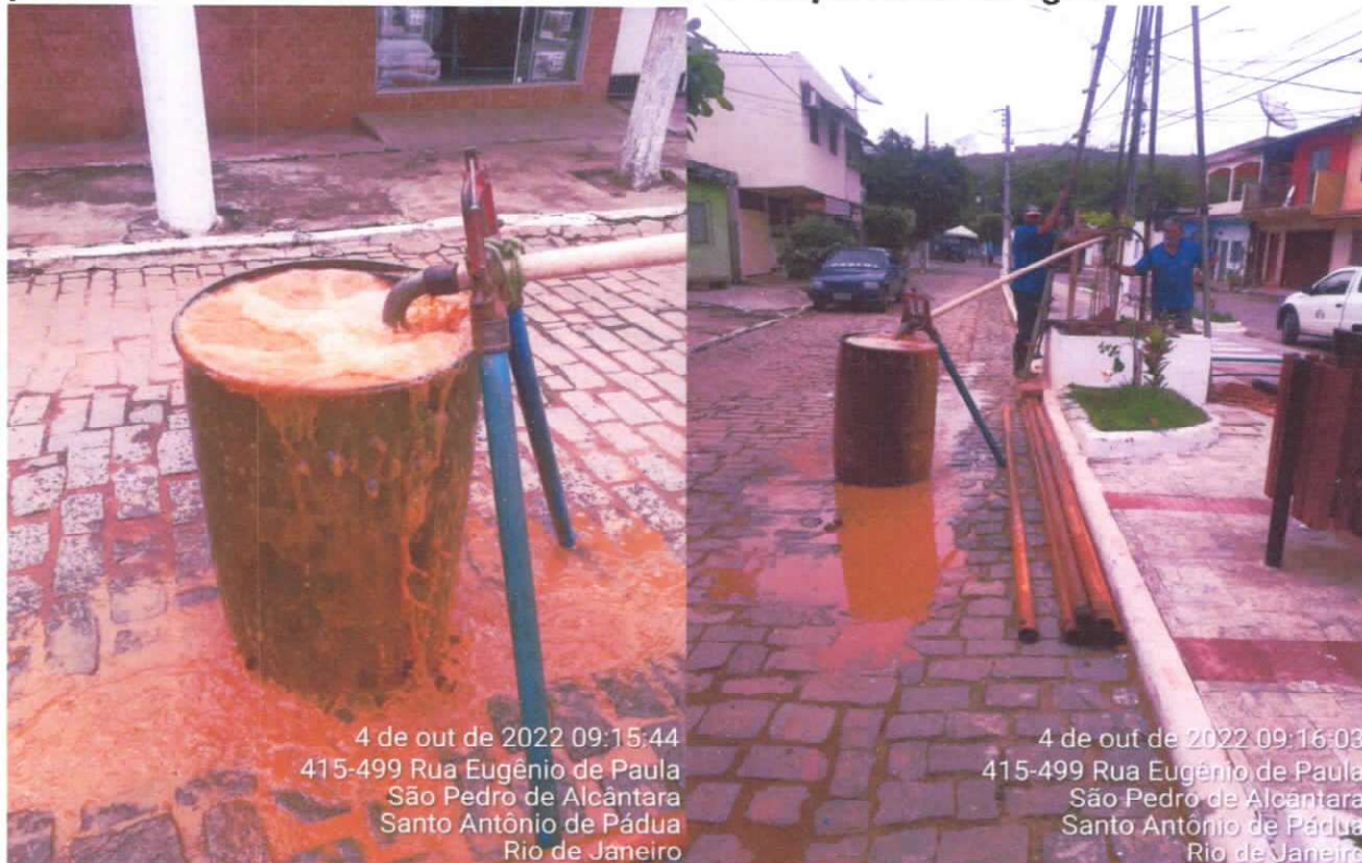
Figura 1 e 2 ; limpeza do poço e retirada da bomba para manutenção.
