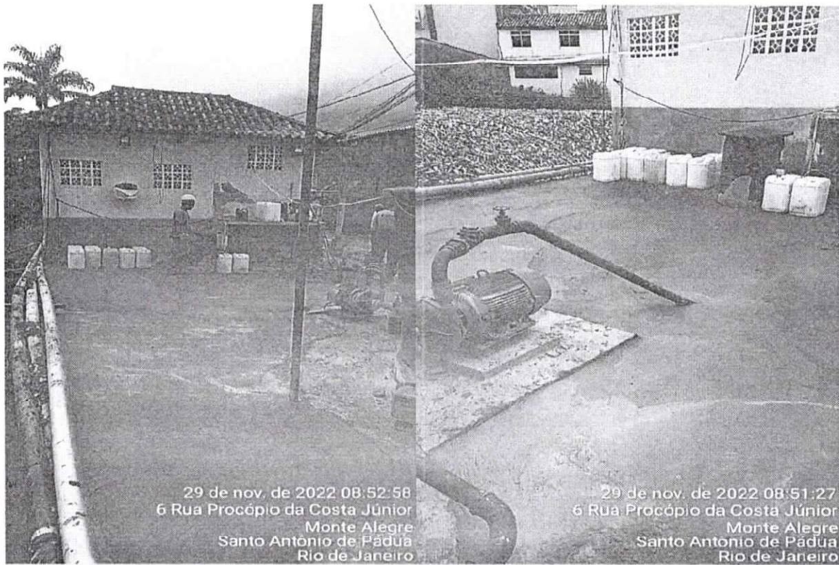
Figura 9 e 10 ; área de trabalho já aterrado e com concreto pronto.
