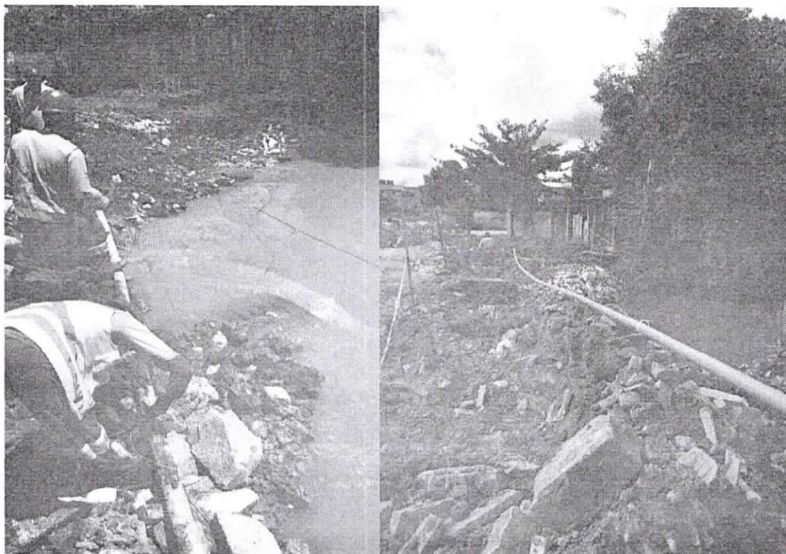
Figura 5 e 6; manutenção da travessia do bairro carvalho, a empresa esteve presente junto a prefeitura em todas as etapas dessa travessia para minimizar os transtornos dessa obra.
