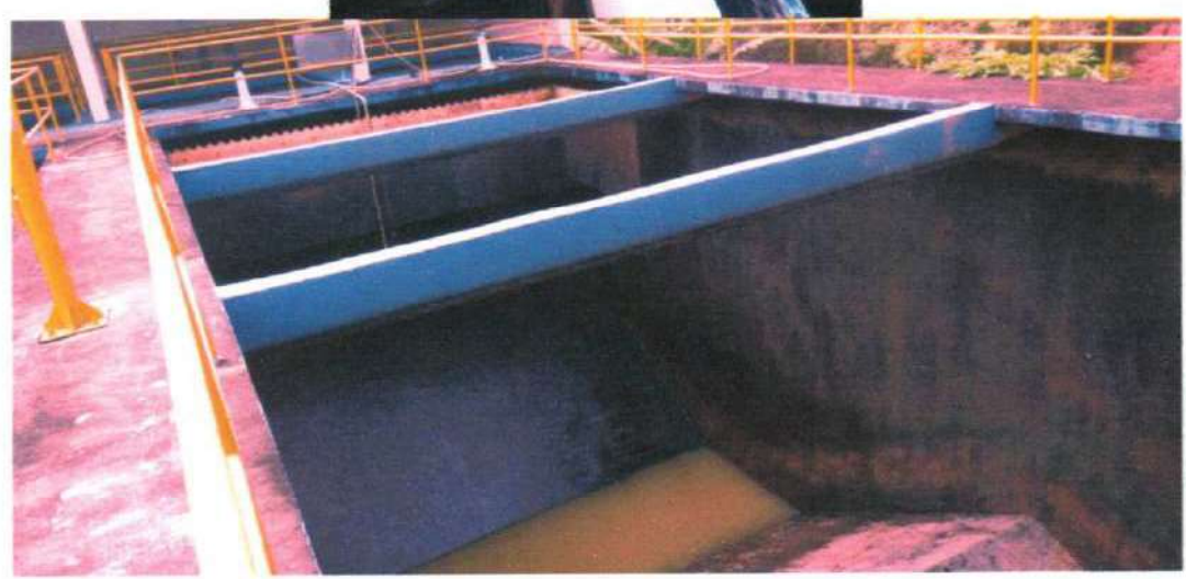
Figura 8 e 9; funcionários realizando o serviço de manutenção e decantador já limpo.
