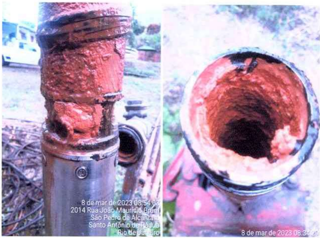
Figura 3 e 4 ; retirada e limpeza da tubulação de recalque e da bomba se sucção.
