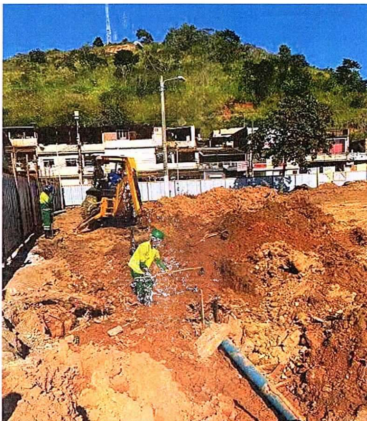
Figura 16: Interligação da rede após retirada de raiz
