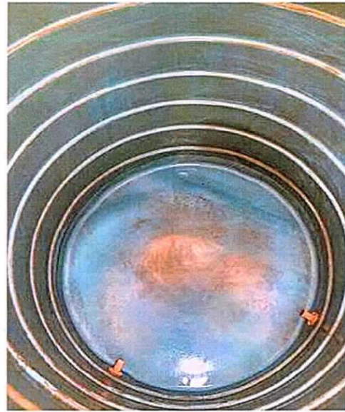
Figura 9: Reservatório em Boa Nova
