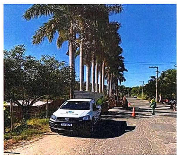
Figura 32: Execução de ligação nova
