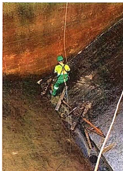
Figura 27: Recuperação de madeira decantador 1
