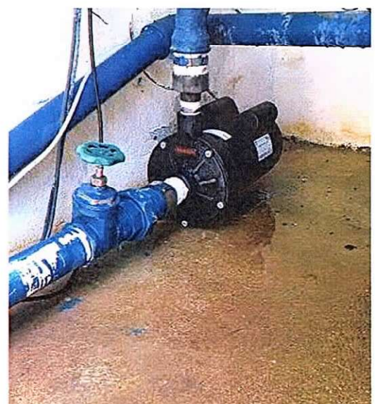
Figura 4: Nova bomba instalada em Agripino
