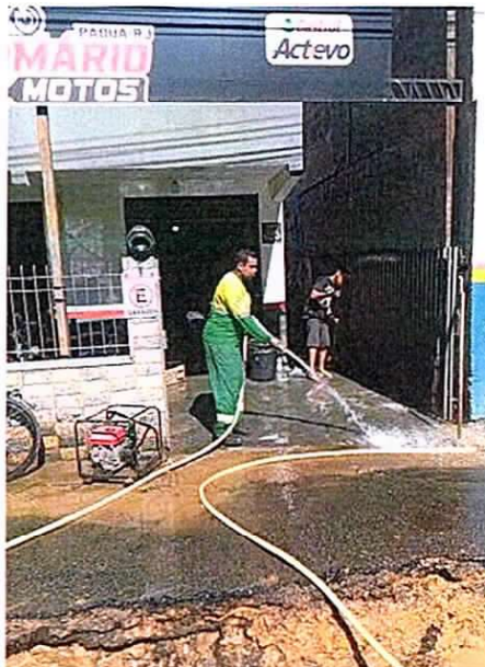
Figura 19: Limpeza externa da oficina
