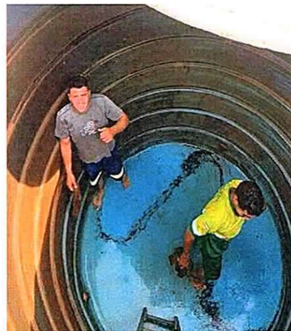
Figura 11: Reservatório em São Pedro
