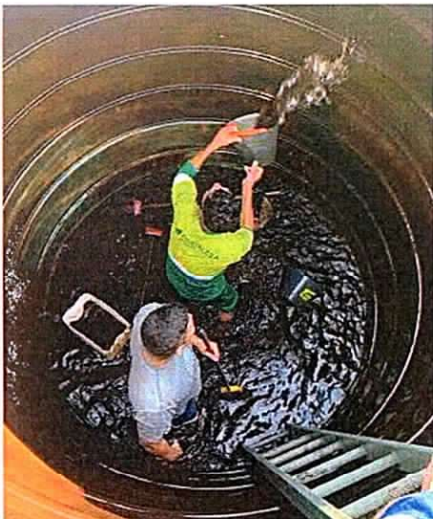
Figura 10: Reservatório em São Pedro
