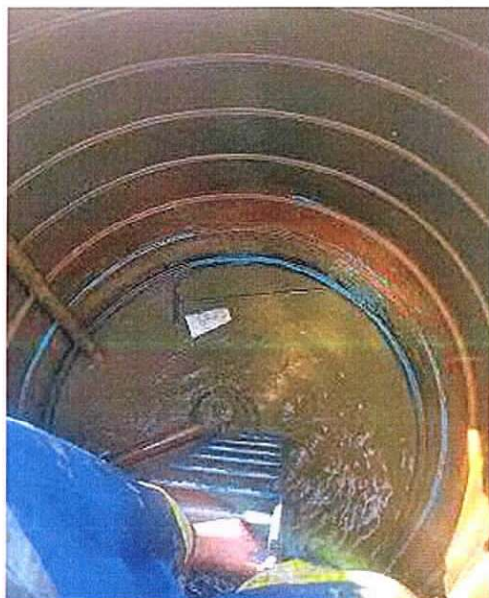
Figura 12: Lavagem Reservatório em M. Alegre
