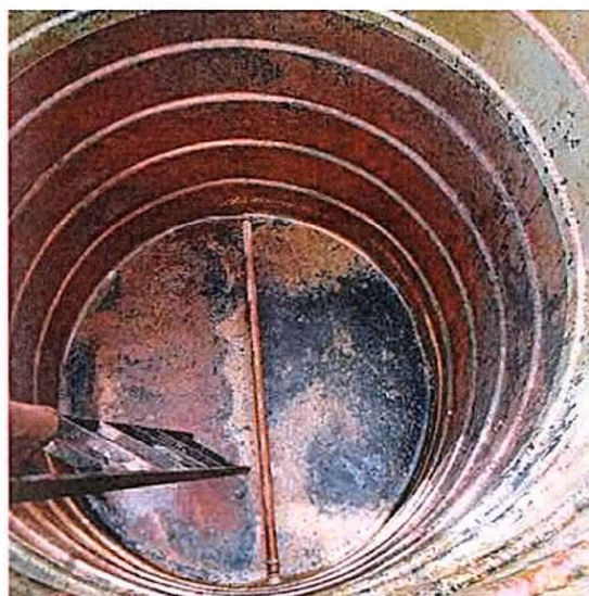
Figura 15: Decantador lavado em São Pedro
