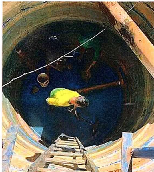
Figura 13: Reservatório ETA Monte Alegre
