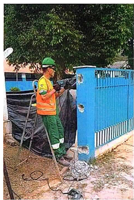
Figura 33: Instalação de portão ETA Salgueiro
