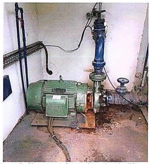
Figura 3: Manutenção na bomba da Elevatória 02
