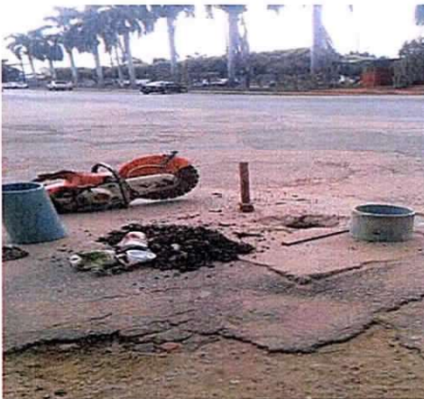
Figura 24: Manutenção de registro de rede
