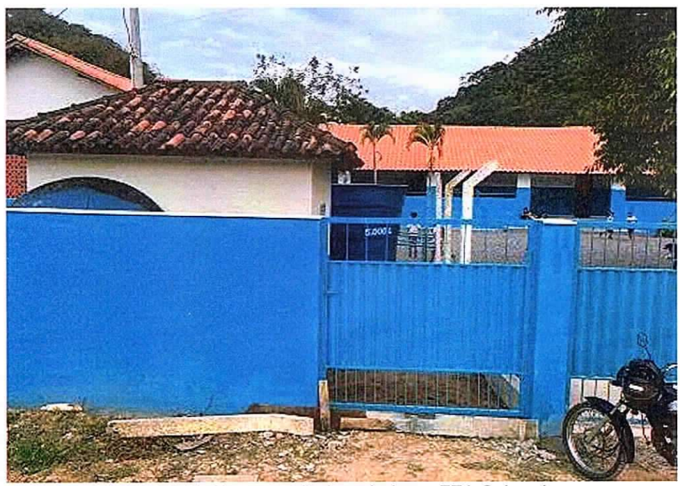
Figura 34: Novo portão instalado na ETA Salgueiro
