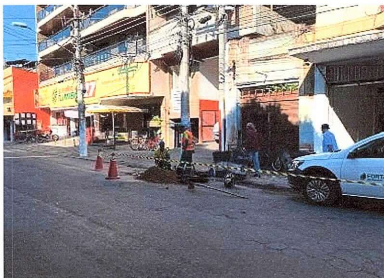
Figura 7: Reparo de vazamento de ramal
