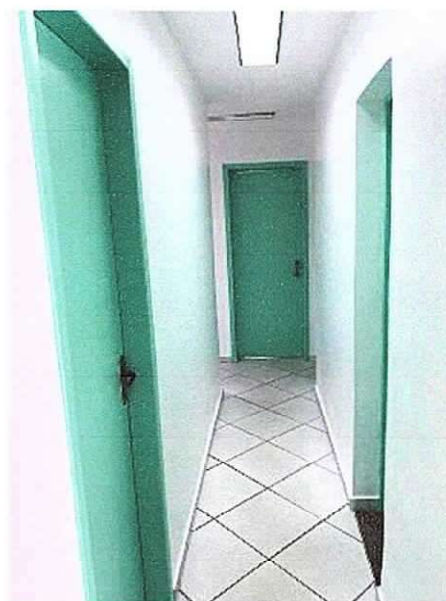
Figura 4: Pintura de portas do escritório comercial
