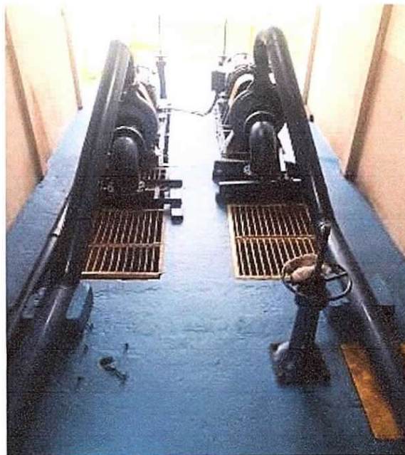
Figura 1: Pintura de piso da captação de água da ETA Principal
