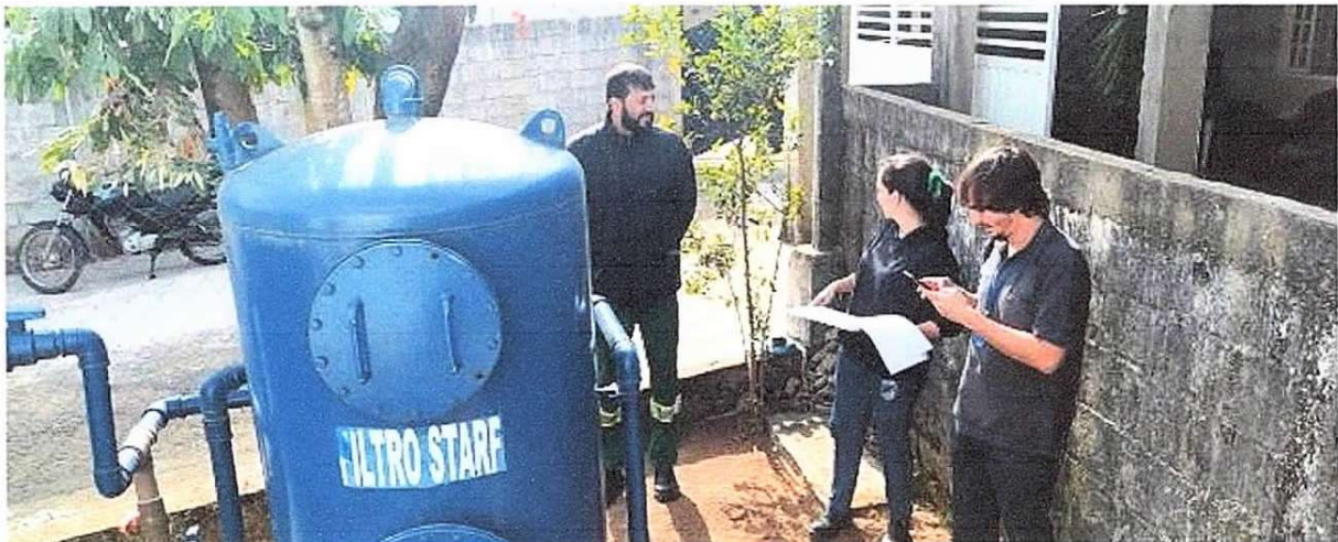
Figura 15: Inspeção nas ETA'S
