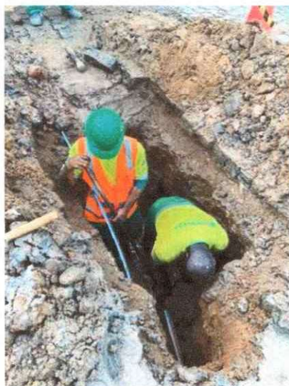
Figura 3: Execução de reparo em rede de abastecimento
