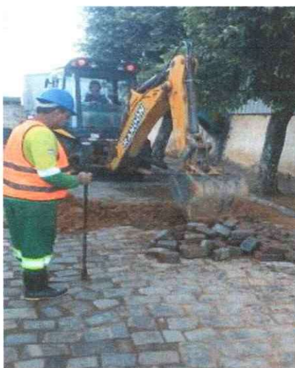
Figura 5: Utilização de retroescavadeira em vazamento
