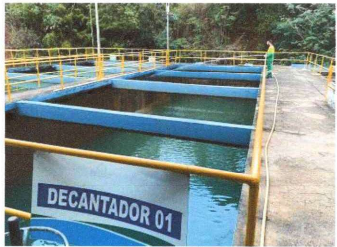
Figura 8: Lavagem decantador
