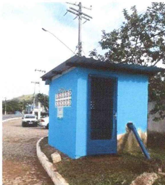
Figura 2: Execução de pintura
