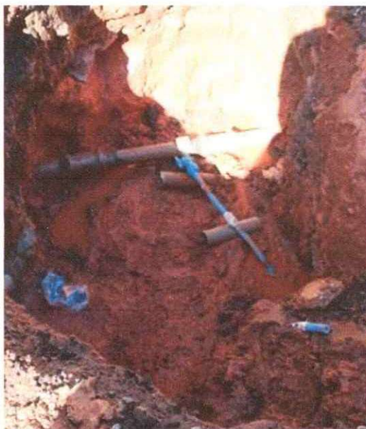
Figura 4: Reparo de vazamento de ramal
