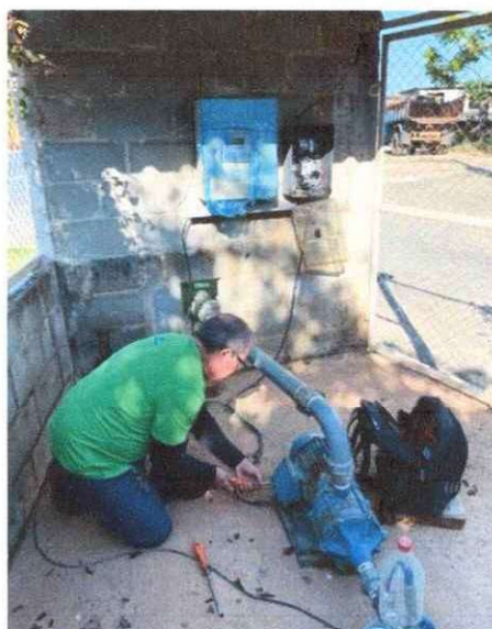
Figura 1: Reparo de bomba em Marangatu
