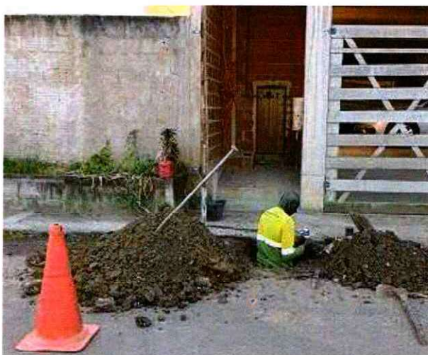
Figura 12: Execução de Ligação nova
