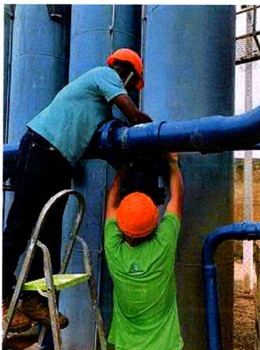
Figura 6: Troca de registro de ferro
