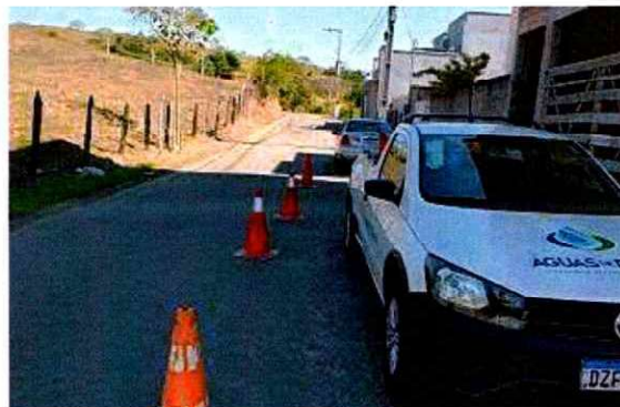
Figura 11: Execução de cortes e religações
