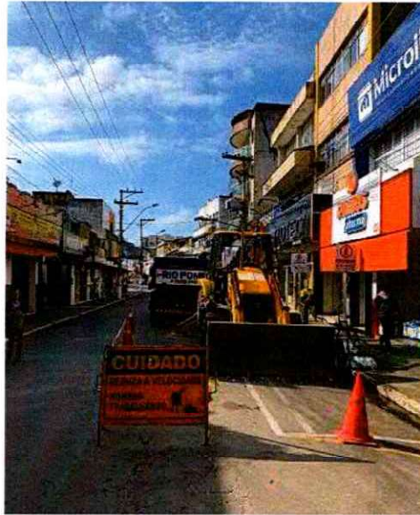
Figura 10: Vazamento de rede na Rua dos Leites
