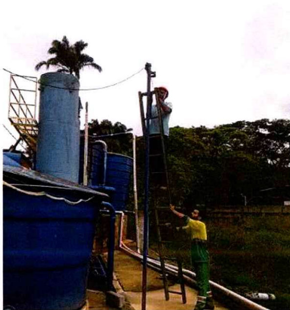
Figura 1: Troca de refletores na ETA Monte Alegre
