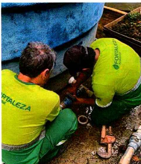
Figura 5: Troca do flange em reservatório de Monte Alegre
