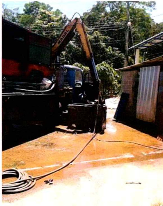
Figura 1: Lavagem do poço em Ibitiguaçu
