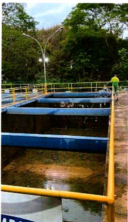
Figura 13: Lavagem decantador 1
