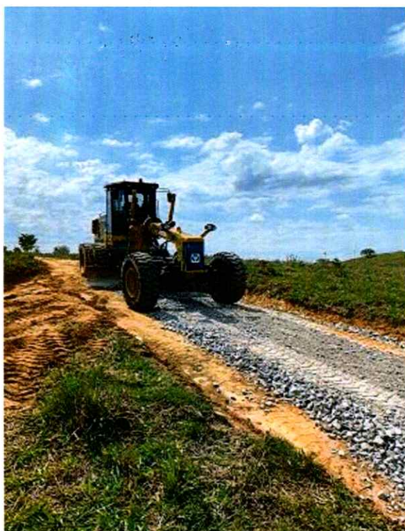
Figura 12: Melhorias na estrada da ETA Cidade Nova
