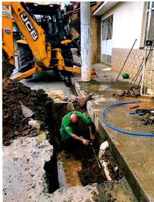
Figura 9: Retirada de ligação clandestina
