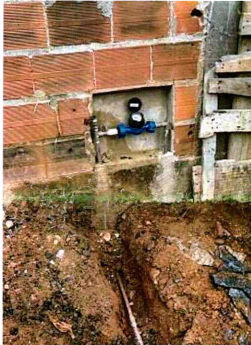
Figura 6: Ligação nova de água em residência
