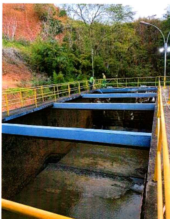
Figura 14: Lavagem decantador 2
