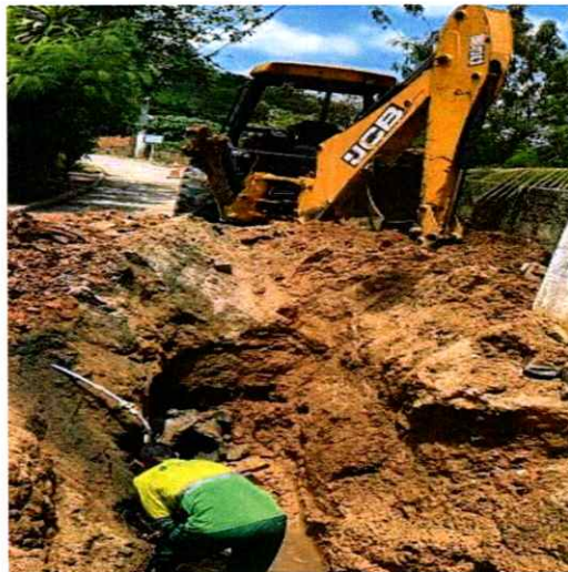
Figura 7: Reparo de vazamento de rede no Bairro Gabry
