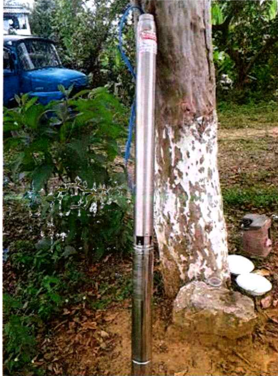
Figura 2: Troca de bomba em Boa Nova
