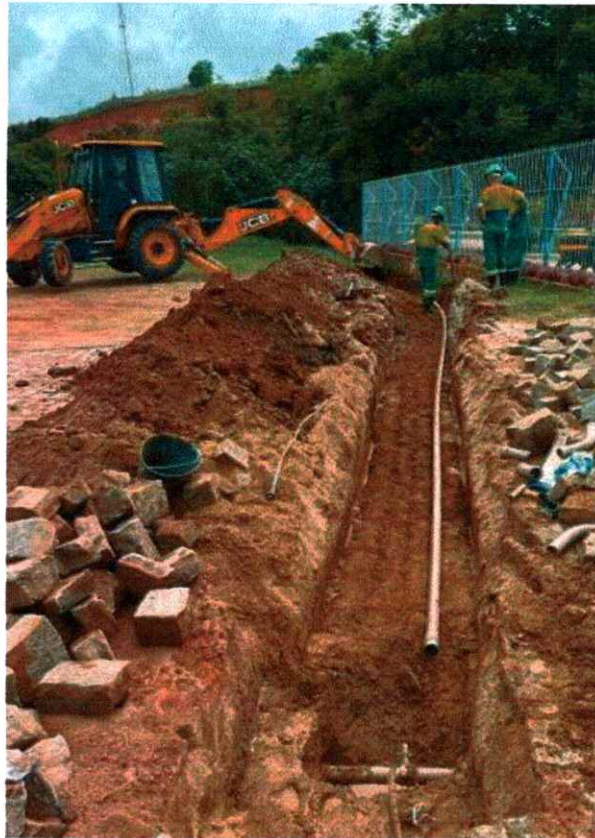
Figura 8: Troca de rede no Parque Municipal
