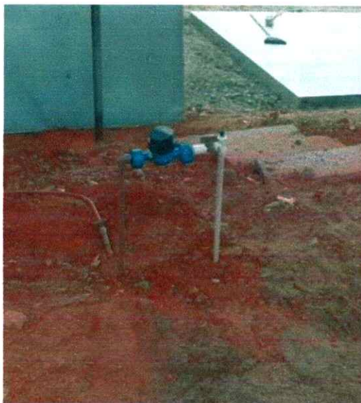
Figura 5: Ligação nova executada
