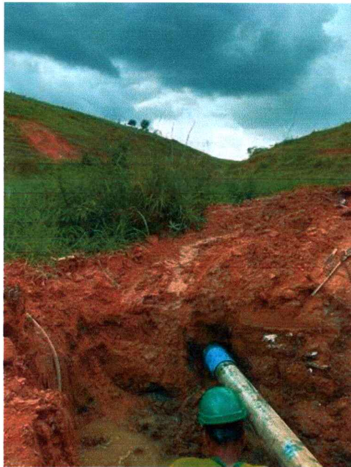
Figura 2: Reparo de vazamento Rede Defofo DN 200mm
