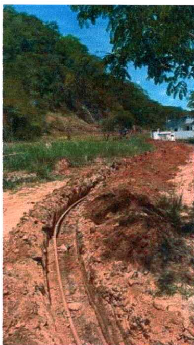
Figura 6: Execução de extensão de rede para ligação nova
