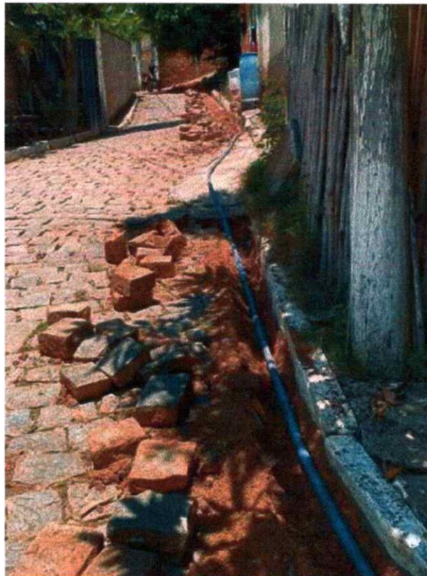
Figura 7: Substituição de rede de abastecimento em São Pedro
