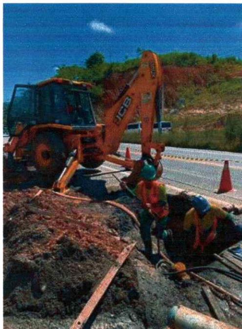
Figura 1: Execução de reparo de vazamento de rede
