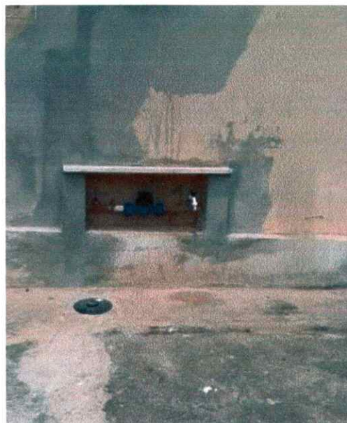
Figura 3: Ligação nova executada
