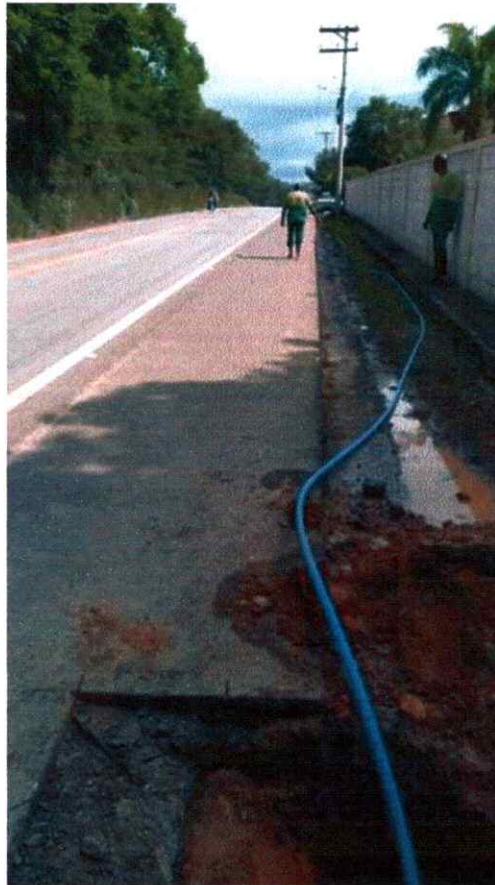
Figura 8: Substituição de rede no Bairro Trajano
