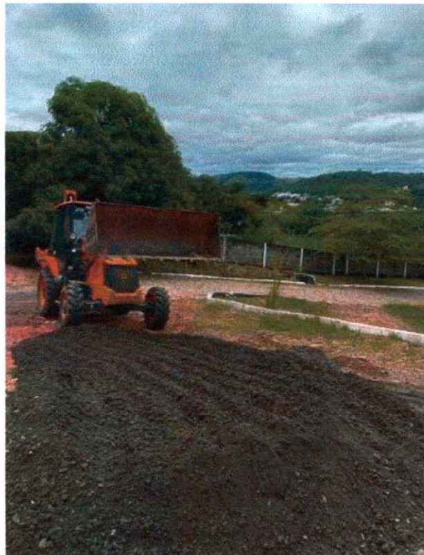
Figura 14: Instalação de bica corrida
