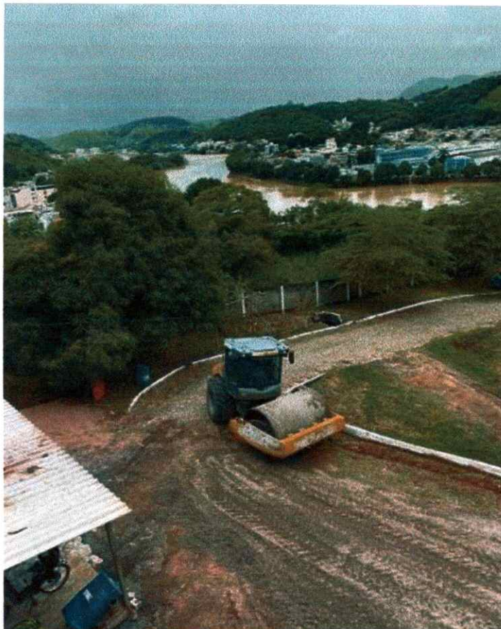
Figura 15: Compactação com rolo
