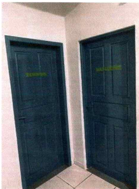
Figura 9: Pintura de portas e paredes.
