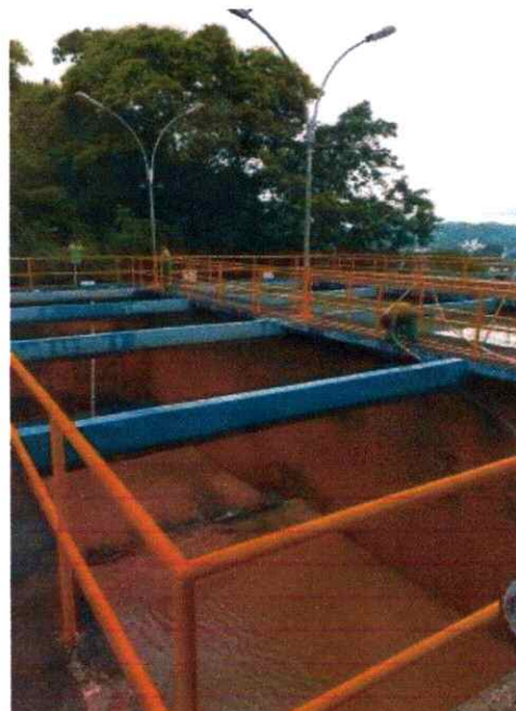
Figura 6: Lavagem decantador 2
