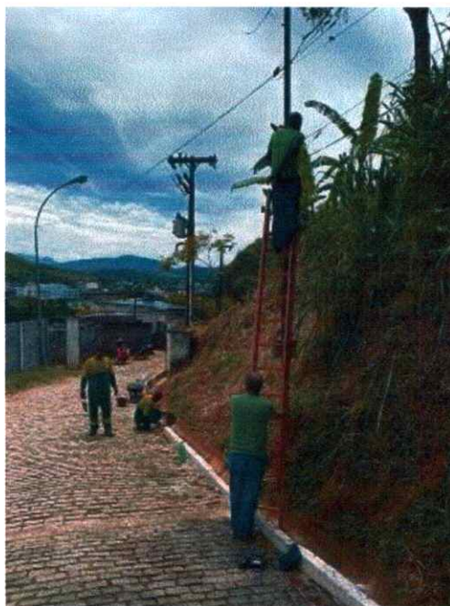
Figura 12: Troca de refletores e caiação de meio fio
