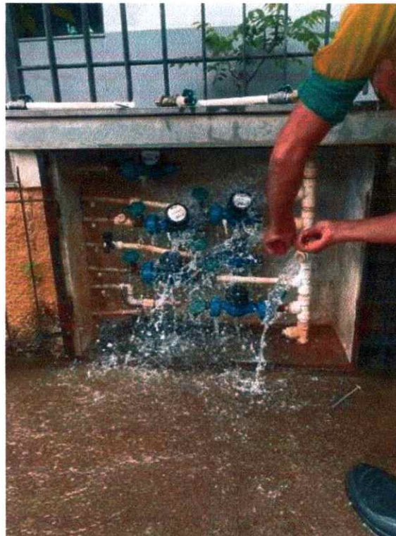
Figura 2: Execução de reparo de vazamento de cavalete
