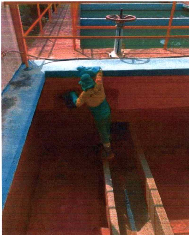
Figura 6: Limpeza de filtro
