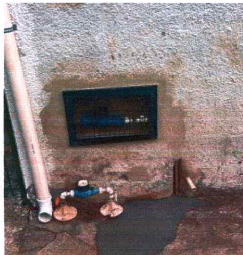
Figura 5: Novo hidrômetro instalado
