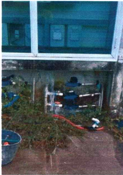
Figura 4: Reparo de vazamento de cavalete
