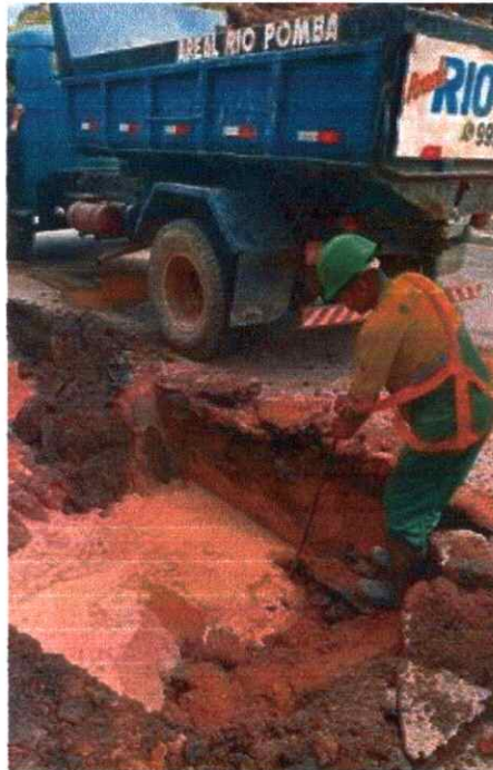
Figura 2: Reparo de vazamento de rede
