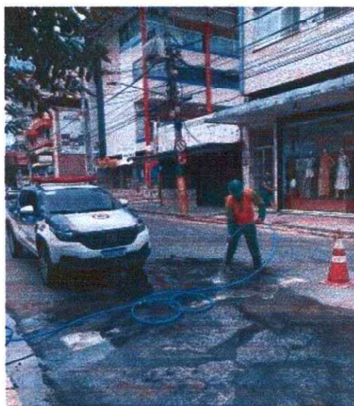
Figura 7: Limpeza do local após reparo do vazamento
