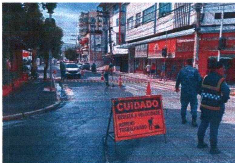
Figura 6: Reparo de vazamento de ramal
