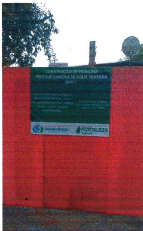
Figura 13: Instalação de Placa de Obra
