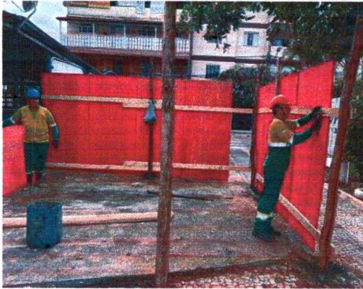
Figura 14: Instalação de Tapume para cercamento de obra
