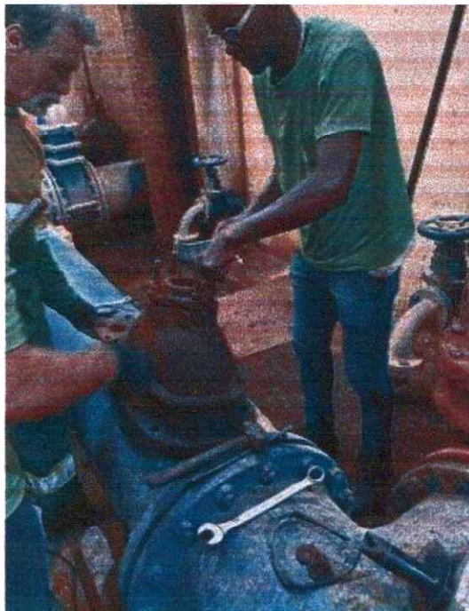
Figura 2: Reparo em registro na ETA Principal
