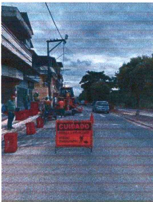
Figura 9: Procura de vazamento na Av. João Jasbick
