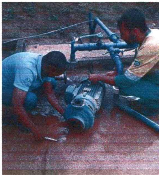
Figura 4: Manutenção na bomba de recalque
