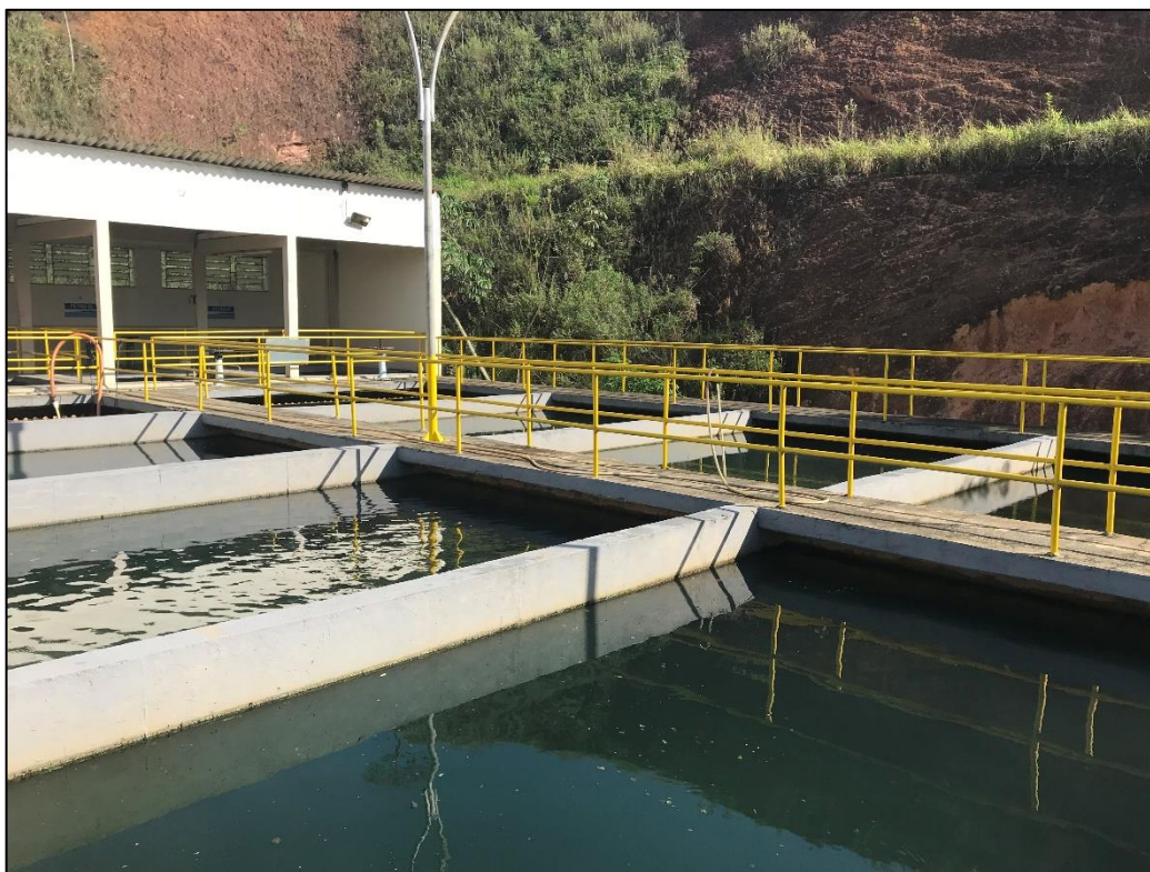
Figura 3.7 - SAA Principal – Filtros.
