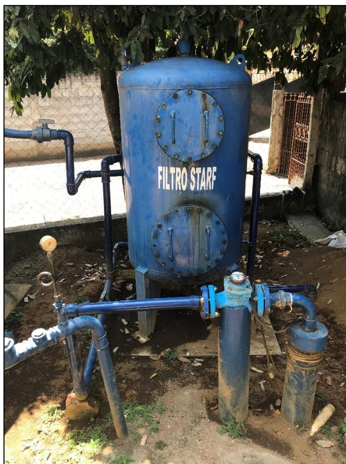
Figura 3.49 - SAA Ibitiguaçu – Filtro Starf.
