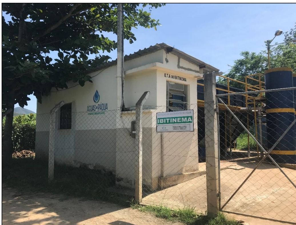
Figura 3.27 - SAA Ibitinema – Estação de tratamento de água.
