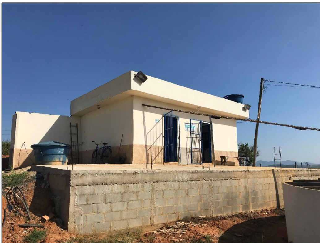
Figura 3.12 - SAA Cidade Nova – Laboratório e banheiro.
