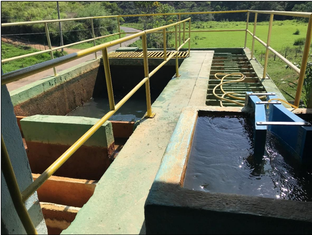
Figura 3.15 - SAA Campelo-Paraoquena – Estação de tratamento de água.
