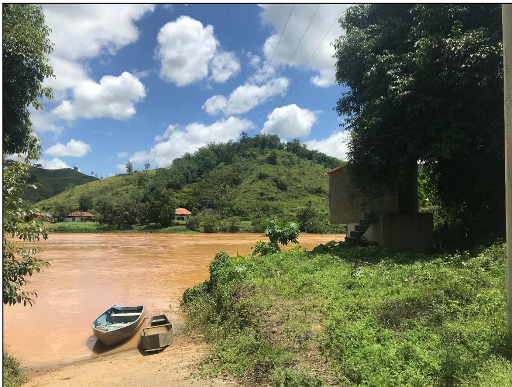
Figura 3.42 - SAA Baltazar - Captação, rio Pomba.
