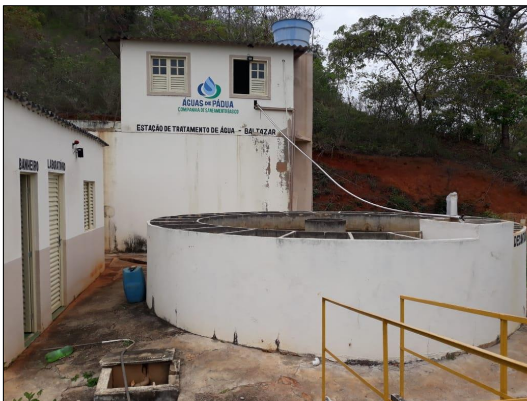
Figura 3.40 - SAA Baltazar - Estação de tratamento de água.
