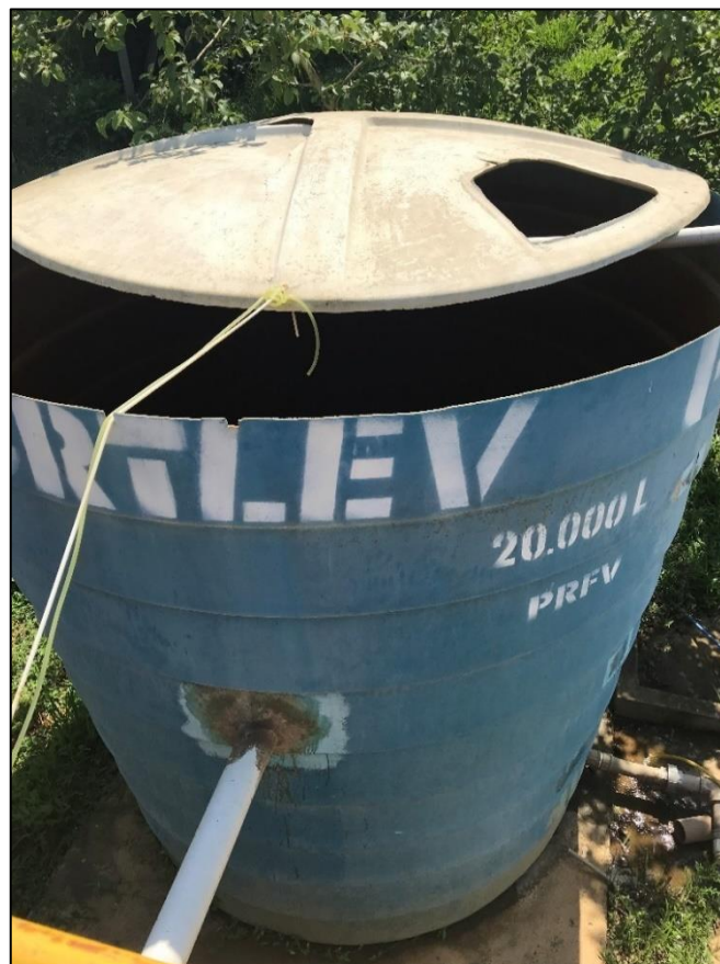
Figura 3.30 - SAA Ibitinema – Reservatório.
