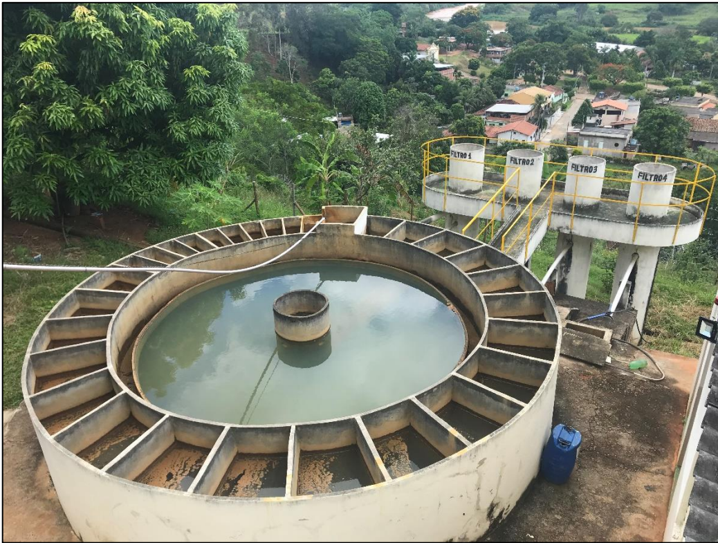
Figura 3.41 – SAA Baltazar - Estação de tratamento de água.
