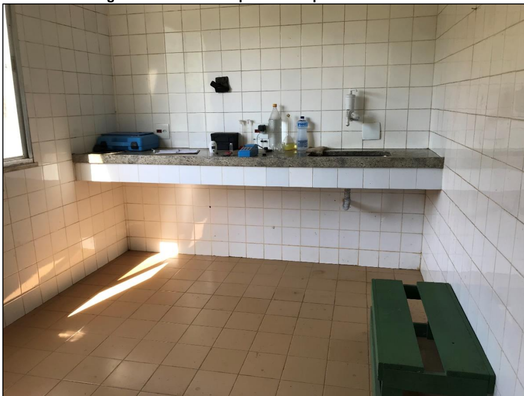
Figura 3.18 - SAA Campelo-Paraquena – Estação de tratamento de água.
