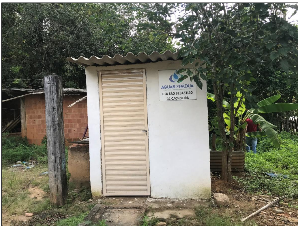
Figura 3.53 - ETA São Sebastião da Cachoeira.
