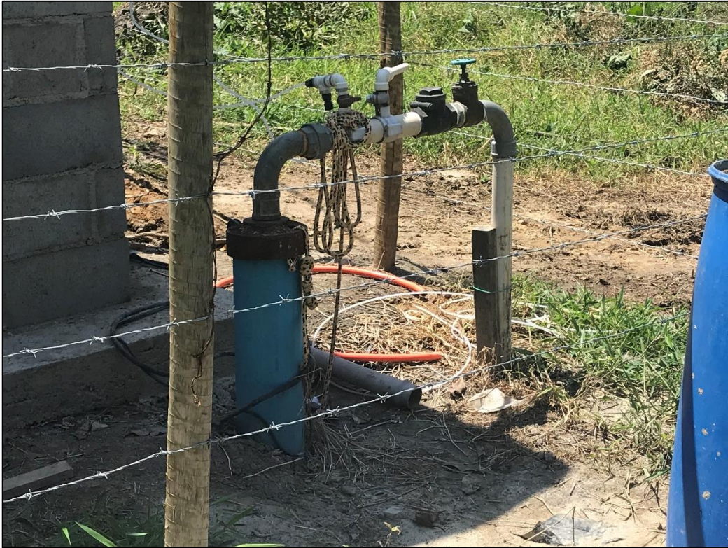
Figura 3.39 - SAA Mangueirão - Poço de captação.
