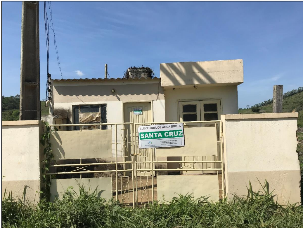
Figura 3.20 - SAA Santa Cruz – Elevatória de água bruta.
