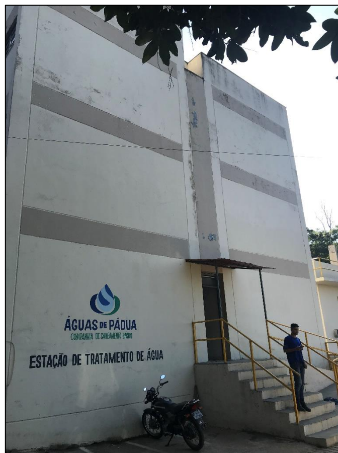
Figura 3.4 – SAA Principal - Estação de tratamento de água.
