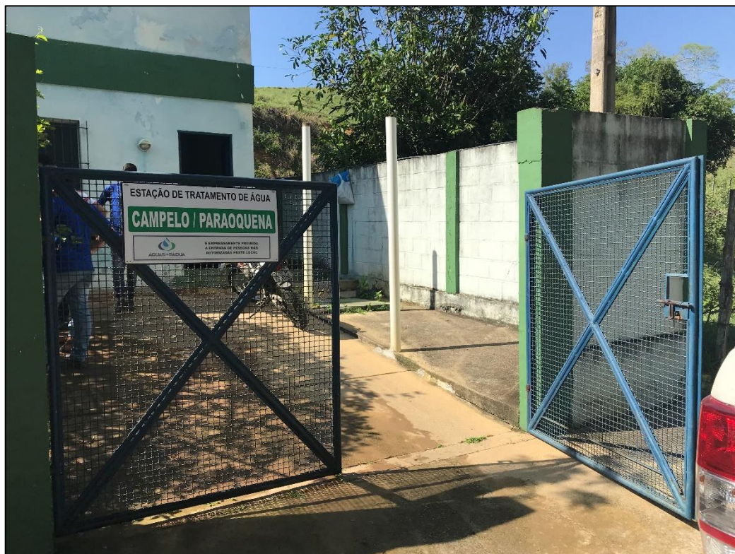
Figura 3.14 – SAA Campelo-Paraoquena – Estação de tratamento de água.
