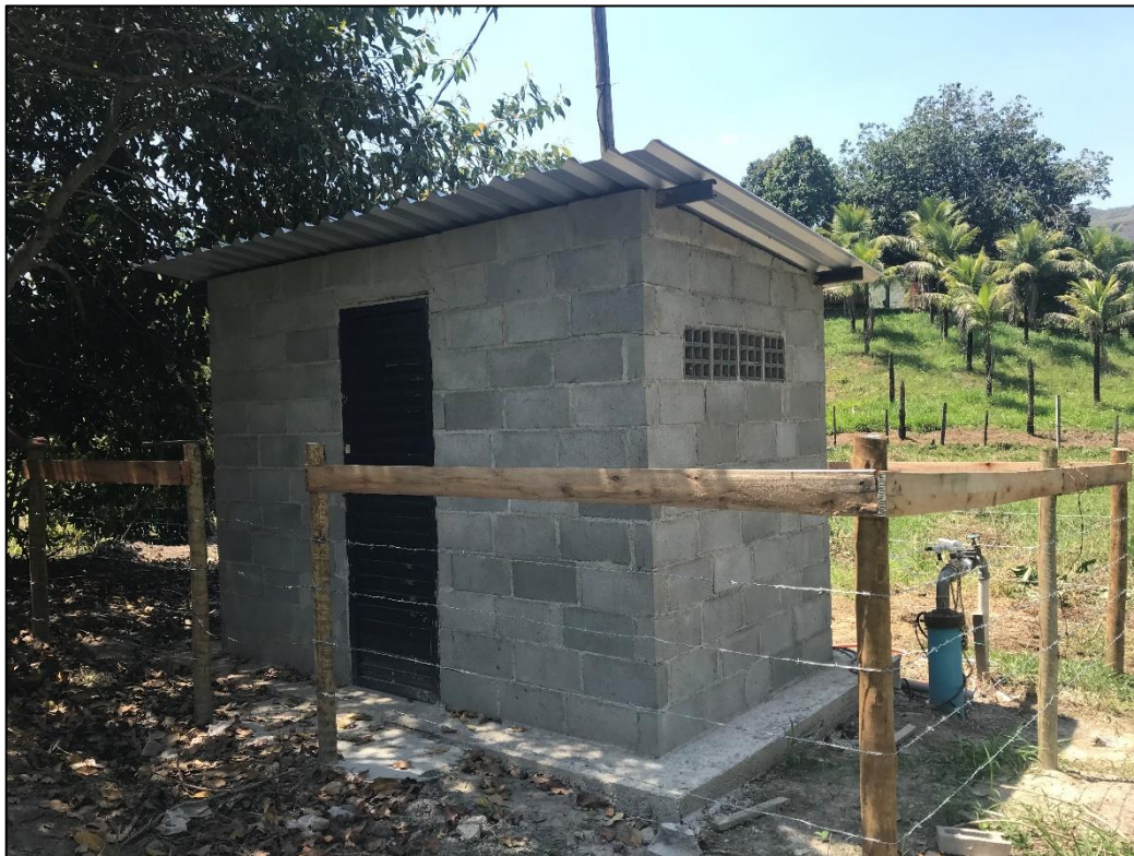
Figura 3.38 - SAA Mangueirão – Poço de captação.
