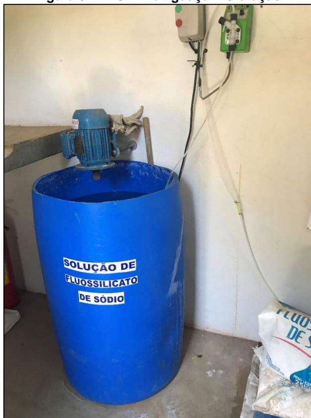
Figura 3.48 - SAA Ibitiguaçu – Fluoretação.
