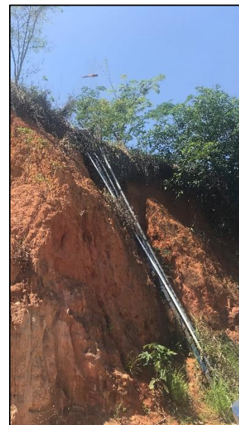
Figura 3.34 - SAA São Pedro de Alcântara – Recalque para reservatório.
